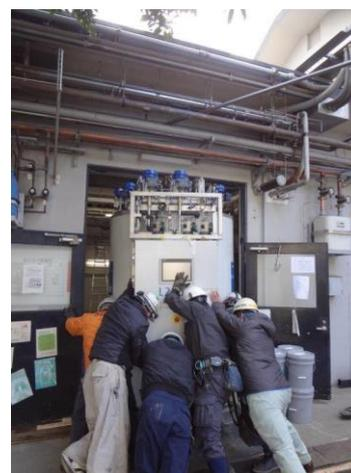
ラフターで吊り上げ搬入される中圧タンク（左）と、ヘリウム液化装置本体（中）。ヘリウム液化室に搬入される新しい液化装置本体（右）。
